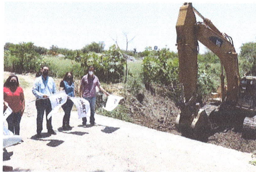
MÁS OBRAS También se dio inicio a la canalización del arroyo La Pagua ubicado sobre carretera Juárez-San Mateo y Fraccionamiento Jardines de Villa Juárez
